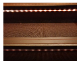
Figur 9-13: Diskret trinnlys som lyser ned langs opptrinnet
